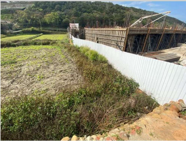
日期：114 年 3 月 12 日 位置：陳錦村田邊-溝渠改善位置
