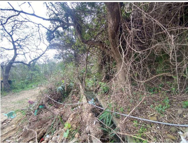
日期：114 年 3 月 12 日 位置：水美路旁延長線補給水路-溝渠改善位置
