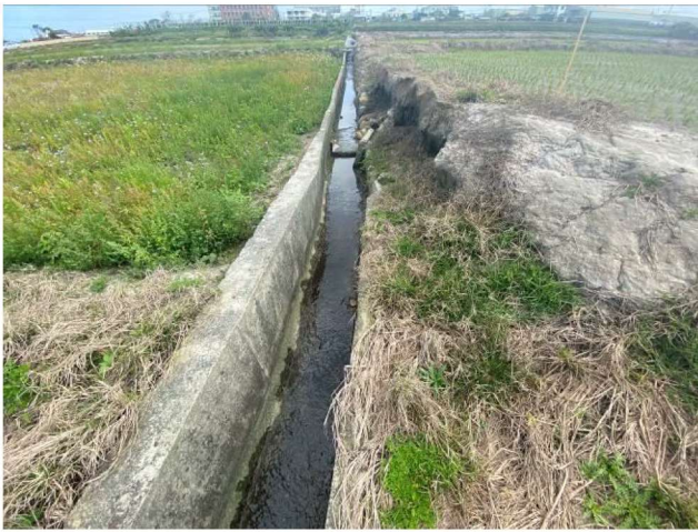
日期：114 年 3 月 12 日 位置：李英河田邊-溝渠改善位置
