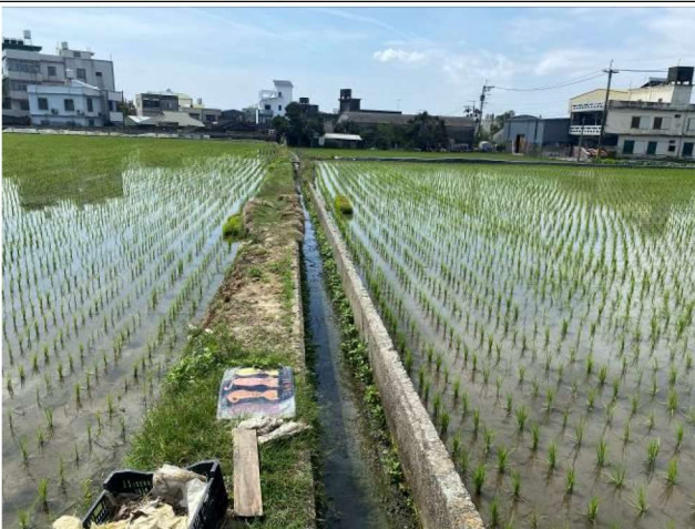
日期：114 年 3 月 12 日 位置：謝火木田邊-溝渠改善位置
