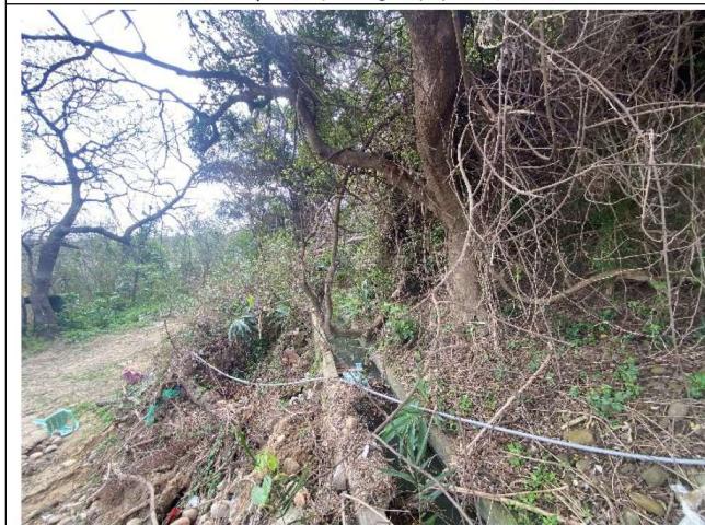
日期：114 年 3 月 12 日 說明：水美路旁延長線補給水路-溝渠改善位置
