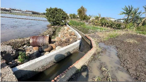
日期：114 年 2 月 17 日 位置：后里圳幹線第 22 小給 2 給水-溝渠改善位置
