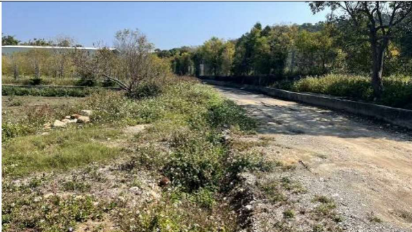
日期：114 年 2 月 17 日 位置：后里圳幹線第 13 小給 2 給水旁-溝渠改善位置
