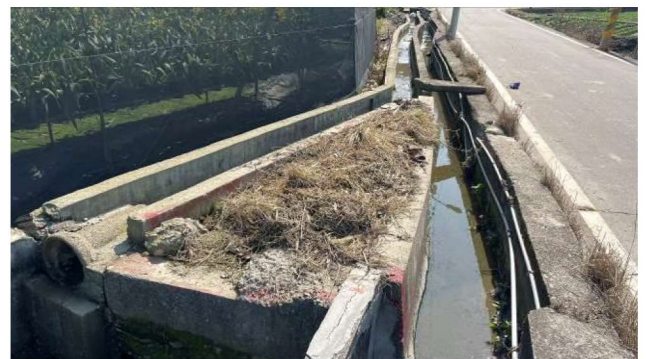
日期：114 年 2 月 17 日 說明：后里圳六支線第 3 小給-工程位置
