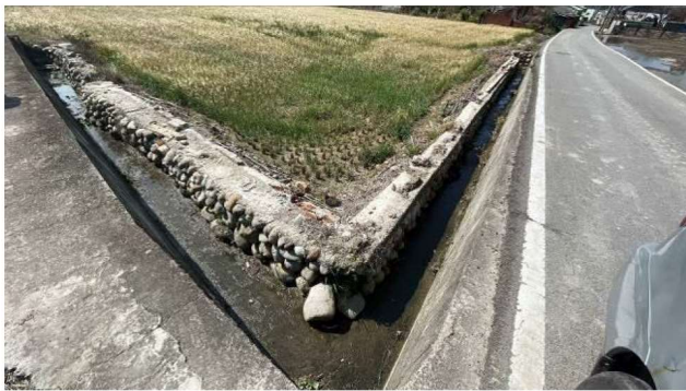
日期：114 年 2 月 17 日 位置：后里圳幹線第 15 小給-溝渠改善位置
