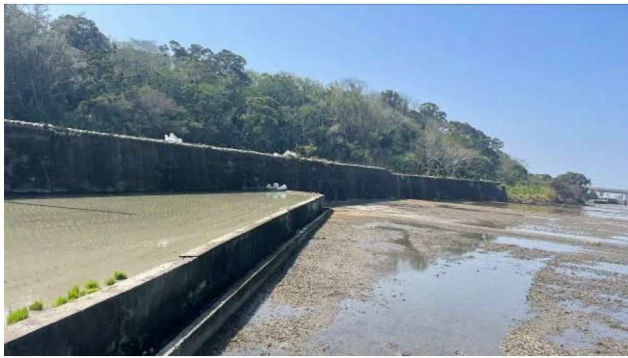
日期：114 年 2 月 17 日 位置：外埔第三排水第 1 補給水路-工程位置
