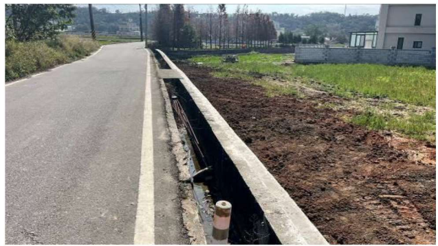
日期：114 年 2 月 17 日 說明：后里圳七支線第 4 小給-溝渠改善位置
