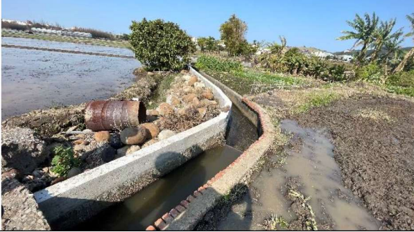
日期：114 年 2 月 17 日 位置：后里圳幹線第 22 小給 2 給水-溝渠改善位置
