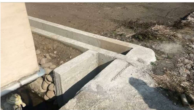
日期：114 年 2 月 17 日 位置：后里圳排水大埔進水口 3 給水旁-溝渠改善位置
