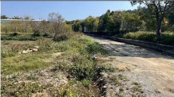
日期：114 年 2 月 17 日 位置：后里圳幹線第 13 小給 2 給水旁-溝渠改善位置
