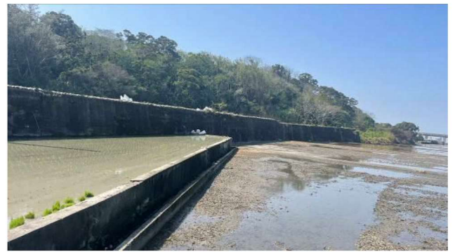
日期：114 年 2 月 17 日 說明：外埔第三排水第 1 補給水路-工程位置
