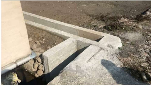
日期：114 年 2 月 17 日 說明：后里圳排水大埔進水口 3 給水旁-溝渠改善位置
