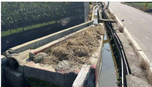
日期：114 年 2 月 17 日 位置：后里圳六支線第 3 小給-工程位置
